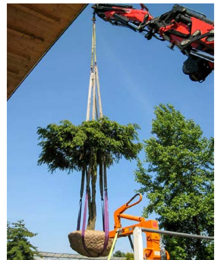
Bei engen Platzverhältnissen kann das Gehölz mit einer Spezialgurte senkrecht verpflanzt werden.
