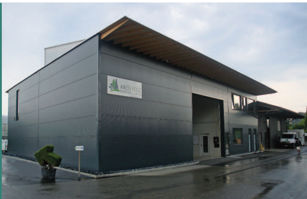
Ein Zweckbau, der Design und Modernität ausstrahlt, ohne die praktische Seite zu vernachlässigen: das neue Betriebsgebäude der Anderegg Baumschulen AG.
